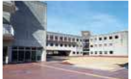
文化福祉会館解体後の跡地整備(防災広場・駐車場)
