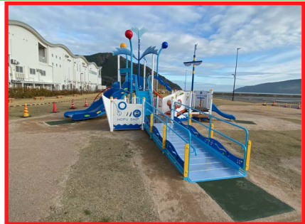
インクルーシブ遊具設置
