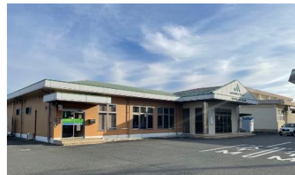
旧JA華城支所を改修
