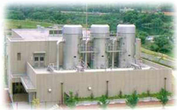
上右田水源地 エアレーション装置
