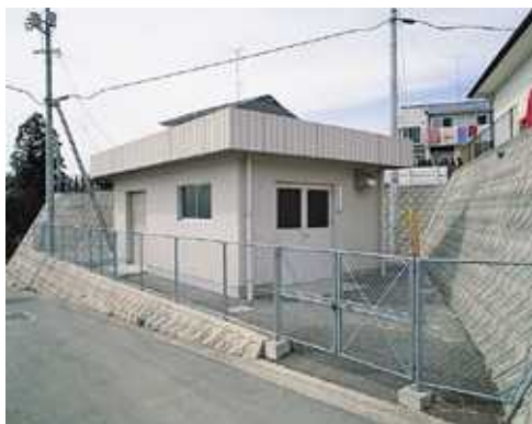
上木部増圧ポンプ所
