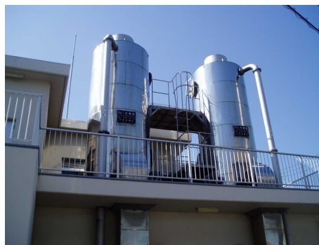
寿第2水源地 エアレーション装置
