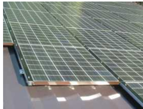
人丸水源地 ソーラー設備
