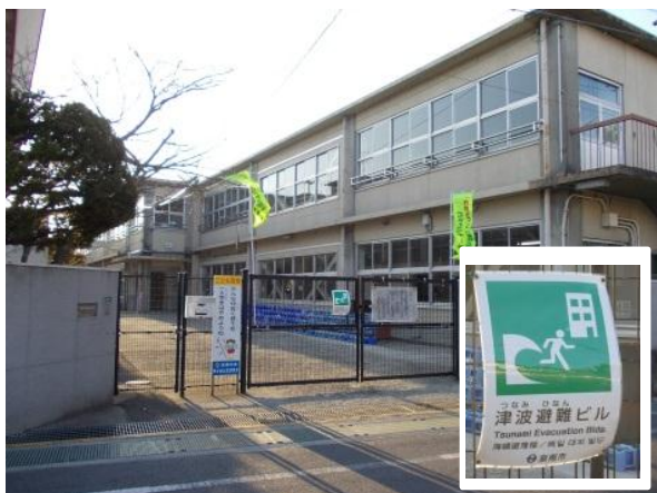
図 2-3-1 津波避難ビル（他市町事例）
