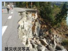
被災状況写真
