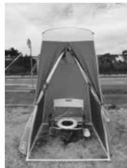
マンホールトイレ
