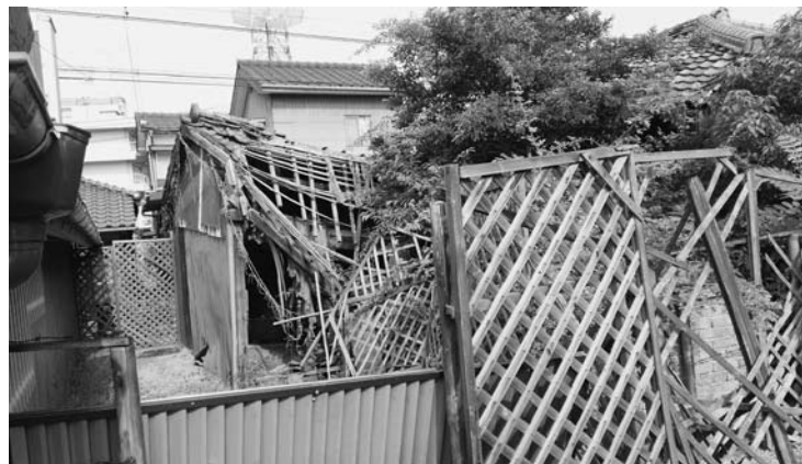
危険な空き家の現状
