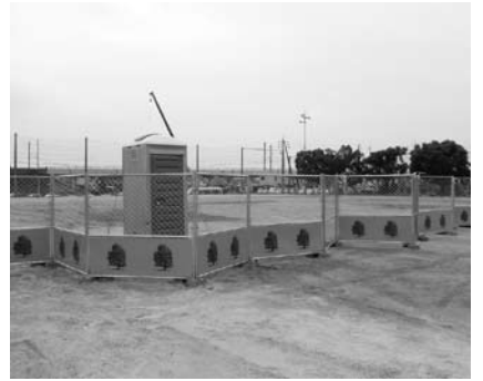
改築工事が始まった右田小学校
