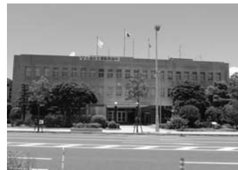
建て替えの対象となっている市役所庁舎
