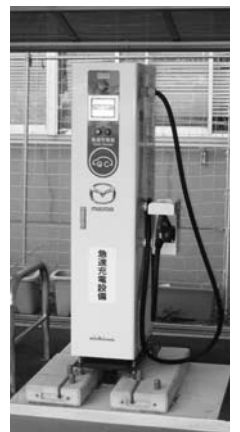
急速充電設備
