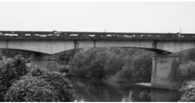
補強が済んだ人丸橋
