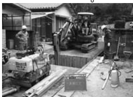
浄化槽設置の風景
