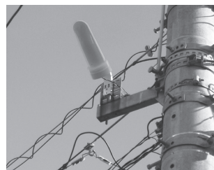
国衙町内に設置したLED防犯灯
