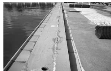
(ひび割れが入った市民プール)
