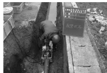
耐震性のある管へ変更
