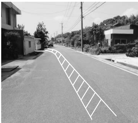
上右田地区の河川改良工事
