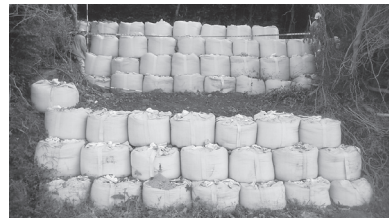
市道牟礼港美濃越線の応急復旧箇所
