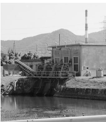
勝間ポンプ場
