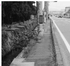
旧力ネボウ前の主要地方道防府環状線の歩道
