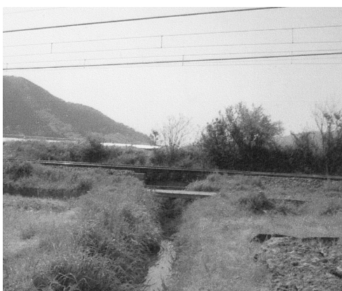
勘場川放水路JR山陽本線横断部
