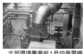
北部環境事業所1号炉発電機
