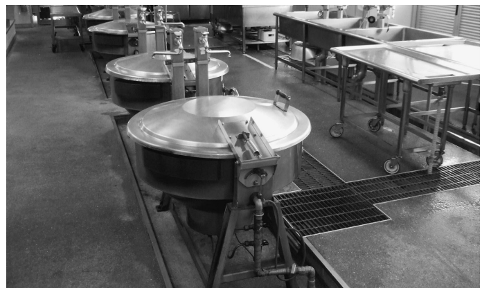
改造が予定される給食室
