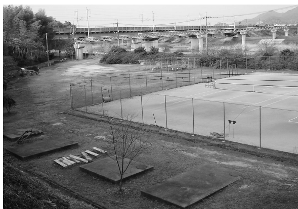
浄水池棟建設予定地(人丸)
