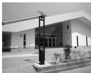
新設された佐波小の街路灯
