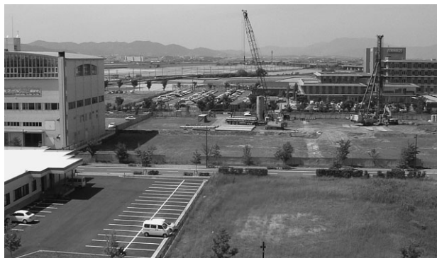
建設中の日本赤十字社九州血液管理センター
