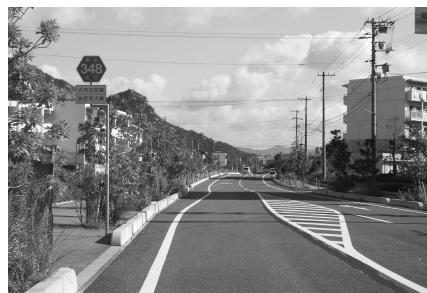
大内右田線の工事完了区画
