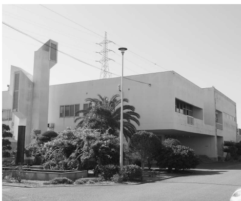
浄化センター
