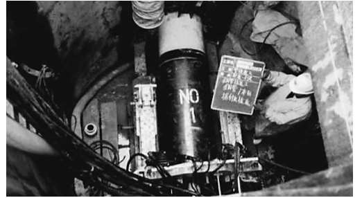
配水管の布設工事(推進工法)
