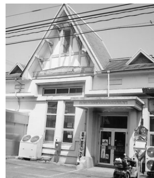
近代化遺産 JA防府とくち華城支所
