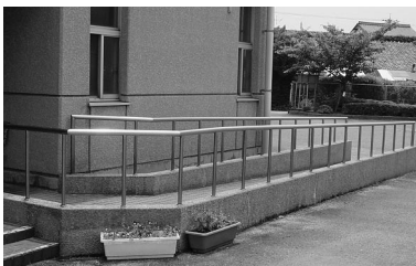
スロープに手すりが設置してある公民館
