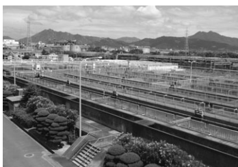
増設工事中の浄化センター
