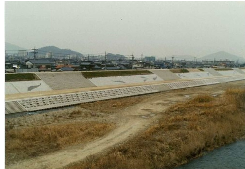
本橋下流・左岸（平成2年度新橋高水第1・第2護岸工事他）
