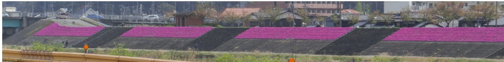
佐波川左岸側法面（平成29年4月21日撮影）
