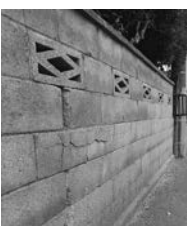
亀裂の入った 空き家のブロック塀
