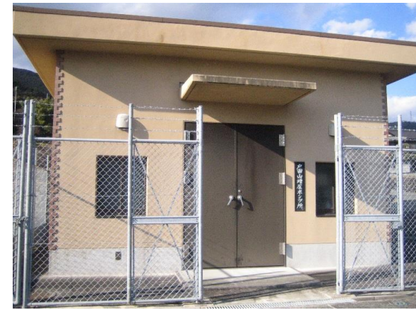
①戸田山増圧ポンプ所
