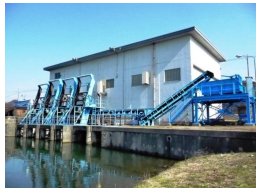
⑥新田ポンプ場
