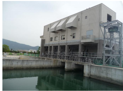
③勝間ポンプ場
