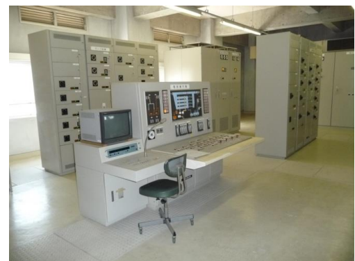
⑧古祖原ポンプ場
