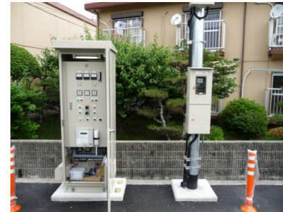
南山手マンホールポンプ
