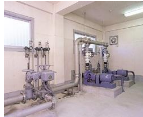
⑤岩島増圧ポンプ所
