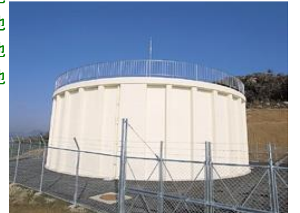
⑤大内配水池
