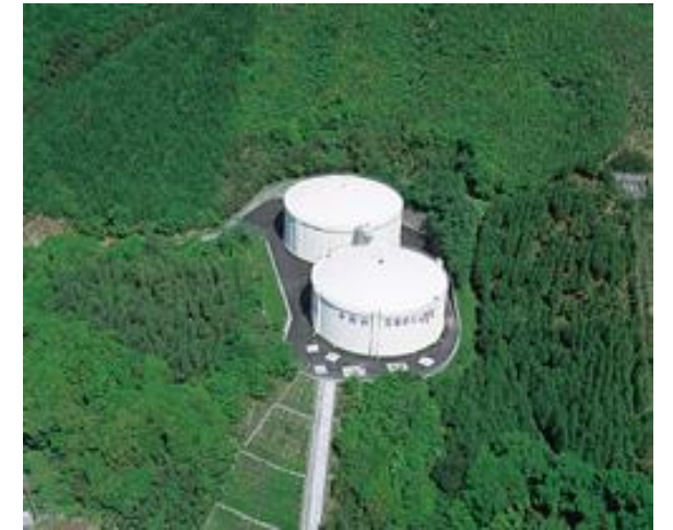
②人丸配水池
