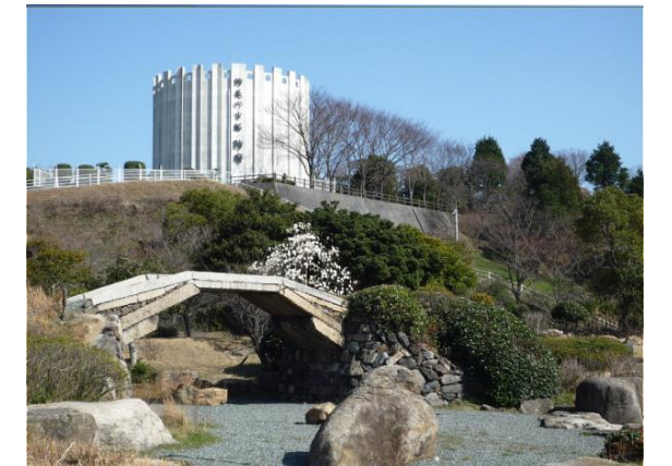
⑬佐野配水池
