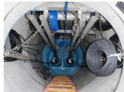
●マンホールポンプ内部
