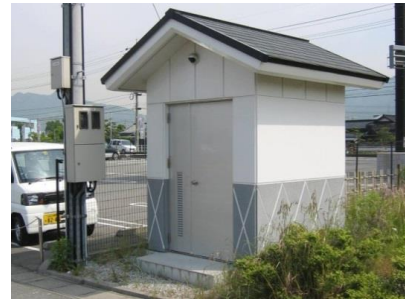
牟礼マンホールポンプ1
