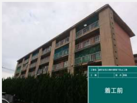
外壁落下防止工事
