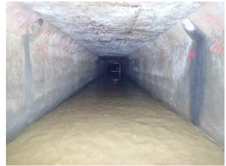
【管更生工事*前】
