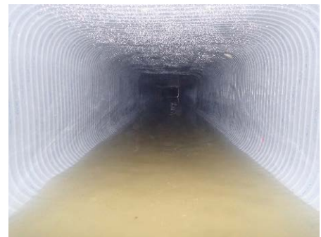
【管更生工事*後】
