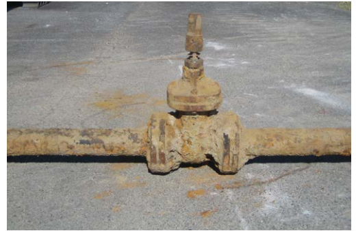
【撤去した仕切弁と管】
