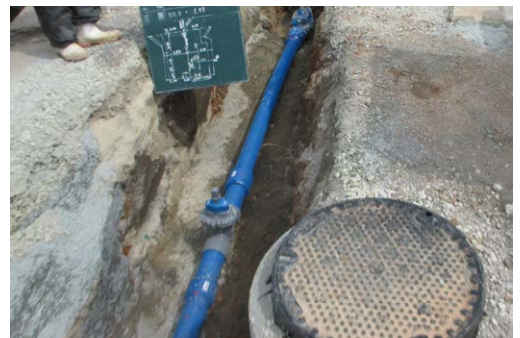
【耐震管の布設工事】
