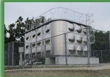
⑮野島配水池
