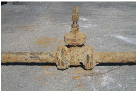
【撤去した仕切弁と管】
