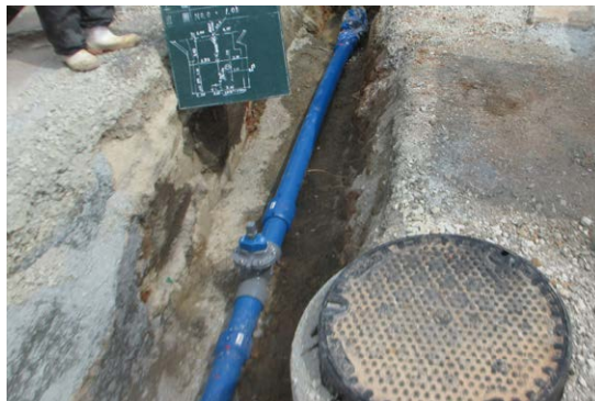
【耐震管の布設工事】
