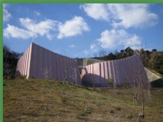
①桑山配水池
