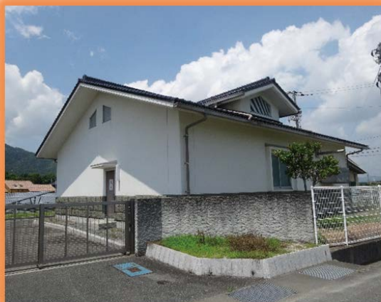
①右田中継ポンプ場
