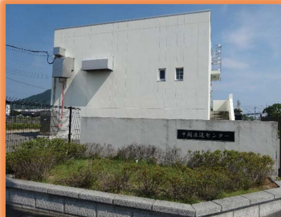
②中関中継ポンプ場
