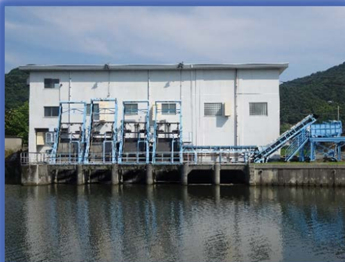
⑤新田ポンプ場
