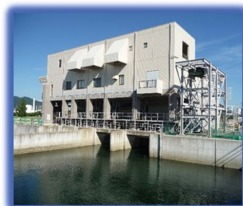
②勝間ポンプ場
