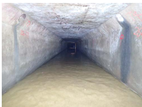
【管更生工事*前】
