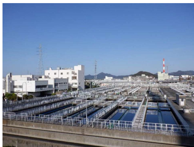
防府浄化センター水処理施設
