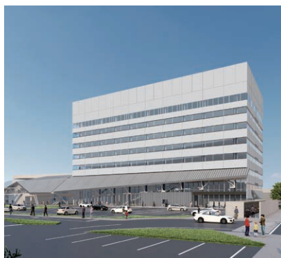
新庁舎の建設
