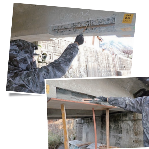
橋りょう補修工事の様子
