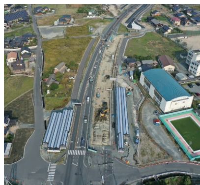
国道2号の拡幅整備
