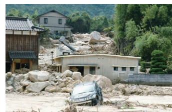
中国・九州北部豪雨により市内で甚大な被害が発生 (平成21年7月)
