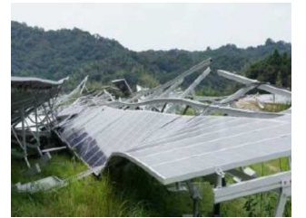
パネル飛散の例-2
