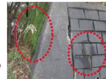
水がしみだしている擁壁 湧水部分にコケが生えている擁壁
