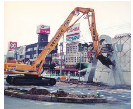
2月16日(水) 投稿【防府駅前広告塔解体】 平成7年5月、防府駅前北口にあった看板広告塔が解体されました。
