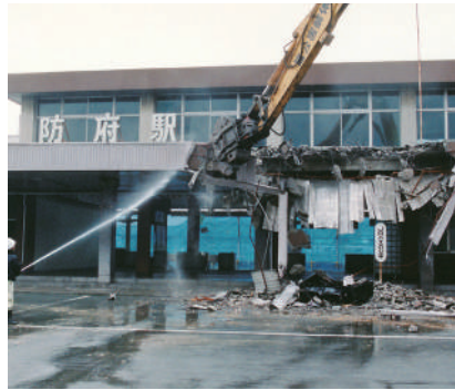
2月10日(木) 投稿【防府駅旧駅舎解体】 平成7年1月、防府駅の旧駅舎の解体が始まりました。
