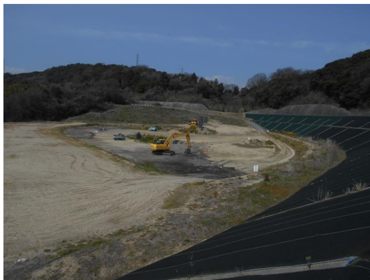
防府市一般廃棄物最終処分場
