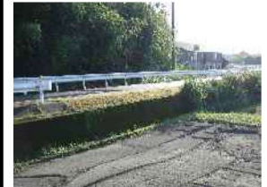
<対策メニュー> 防護柵の設置
