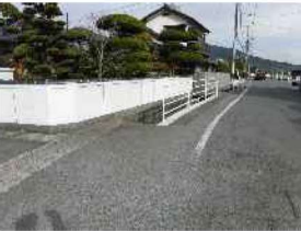
<対策後> <対策メニュー> 転落防止柵の設置
