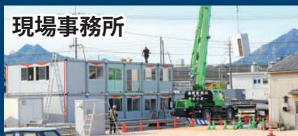
4月の新庁舎建設工事は、現場事務所の設置工事と、建設予定地周囲の仮囲い設置工事を行いました。大規模な工事で作業者も多人数となるため、現場事務所も2階建ての大型のものを設置しています。
