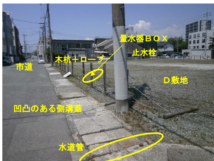
写真7 D敷地南東側（東側→西側へ撮影）
