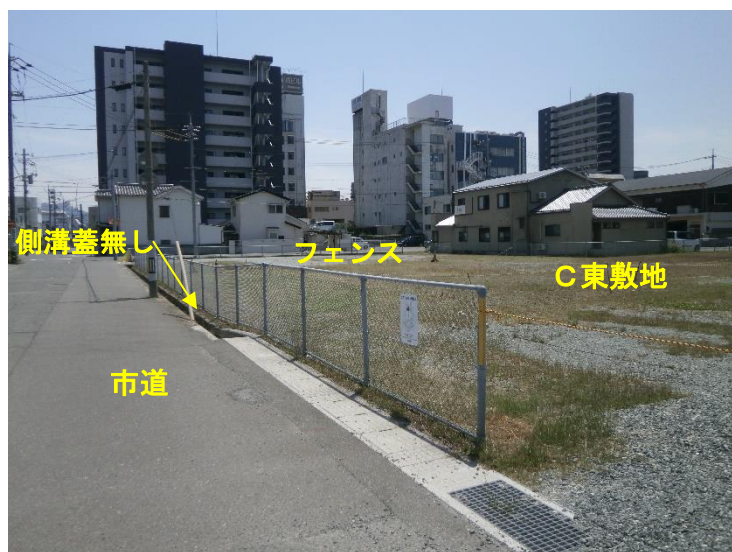
写真10 C東敷地北側（西側→東側へ撮影）
