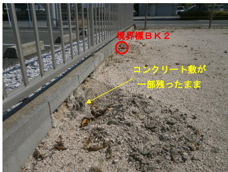
写真38 A敷地南東側（北側→南側へ撮影）
