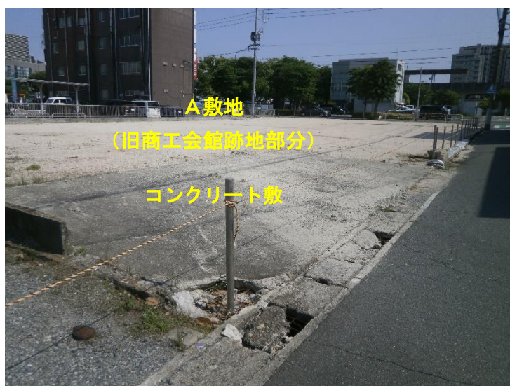
写真32 A敷地西側中央付近（北西側→南東側へ撮影）
