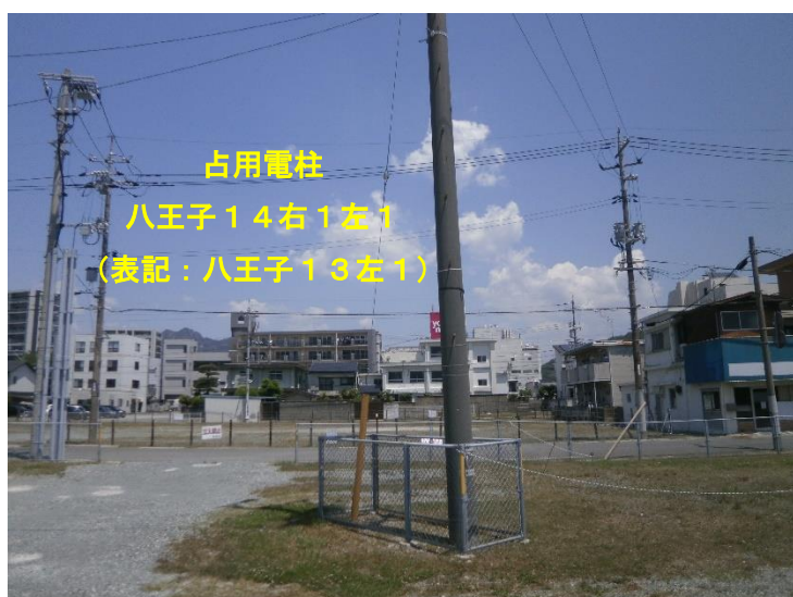
写真3 C東敷地内（電柱向かって南側→北側へ撮影）
