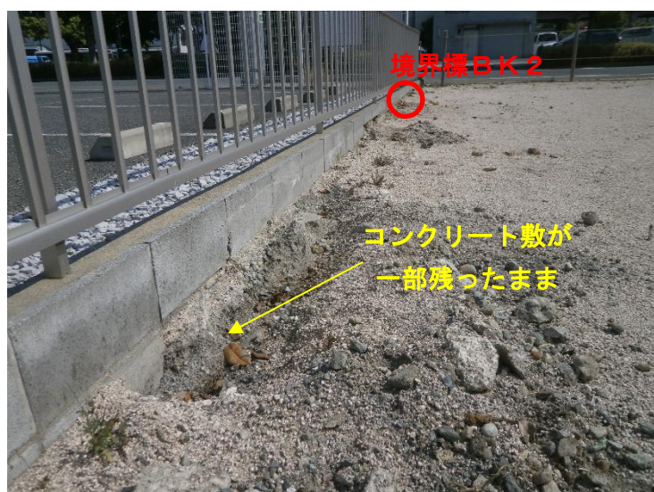
写真39 A敷地南東側（北側→南側へ撮影）
