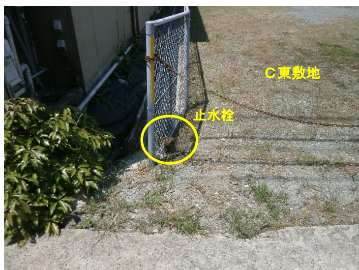
写真16 C東敷地南東側（東側→西側へ撮影）
