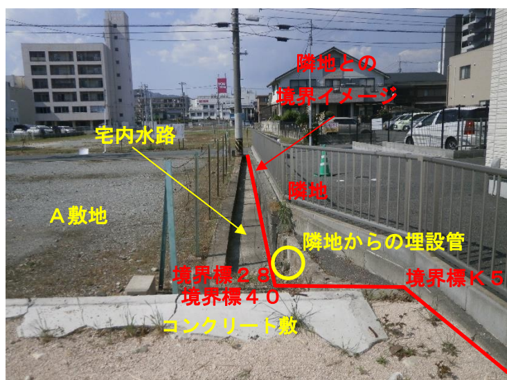
写真40 A敷地北東側（南側→北側へ撮影）
