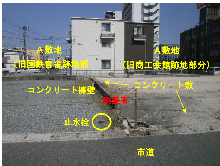
写真 3 3 A 敷地西側 (西側→東側へ撮影)
