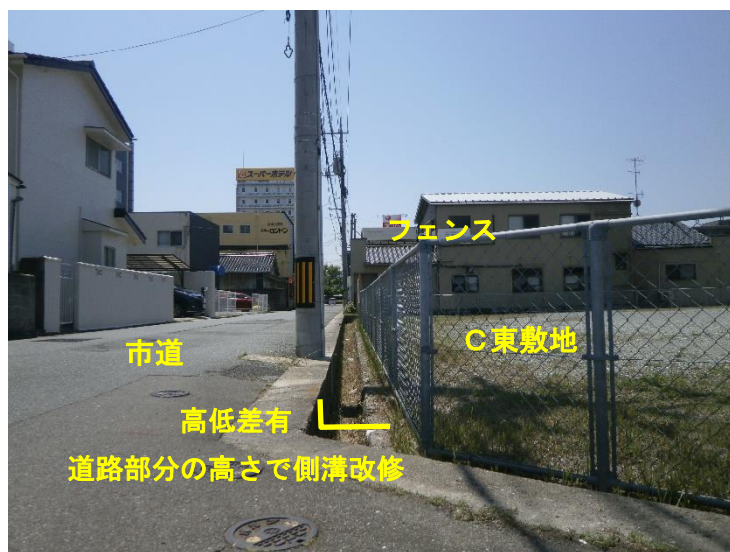
写真15 C東敷地北東側（北側→南側へ撮影）
