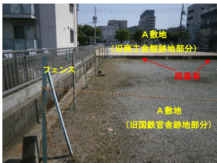
写真29 A敷地北東側（北側→南側へ撮影）
