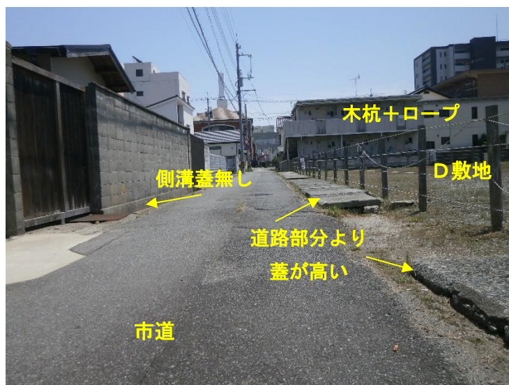
写真1 D敷地北側（西側→東側へ撮影）
