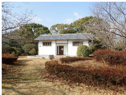
史跡公園トイレ(改修前)
