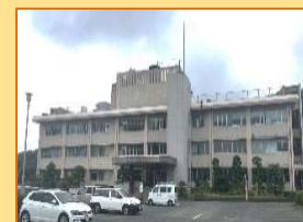
山口県防府総合庁舎
