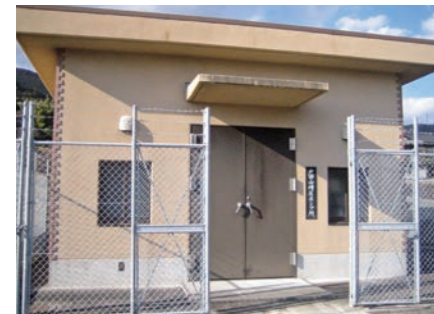
① 戸田山増圧ポンプ所
