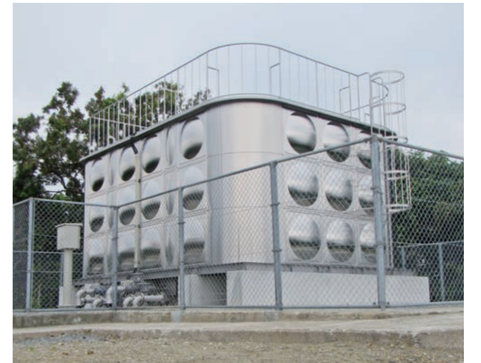
⑮ 野島配水池
