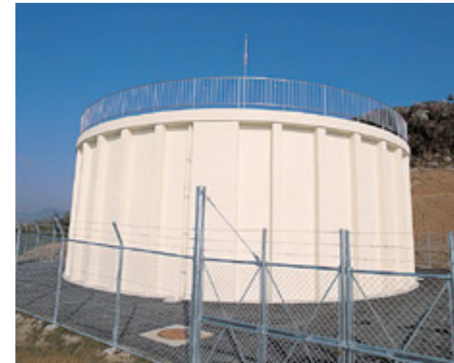
⑤ 大内配水池
