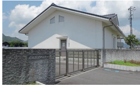
①右田中継ポンプ場
