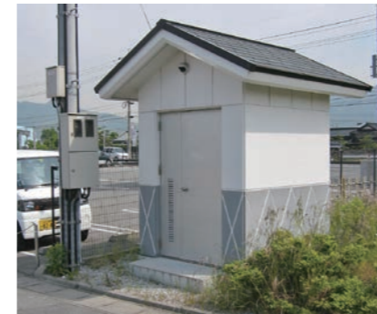
牟礼マンホールポンプ1
