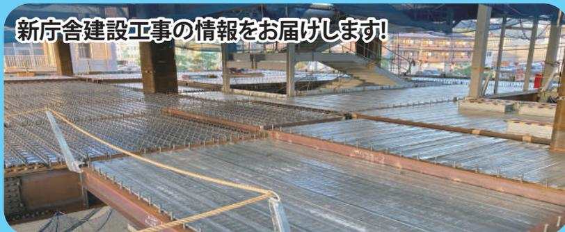
10月は、9月に続いて建物の骨組み工事を行い、5階床までの柱・梁・床がおおむね組みあがりしました。柱や梁をボルトで連結して組み立てるため、工事が目に見えて進んでいきます。11月は、5階より上階の鉄骨工事を行う予定です。
