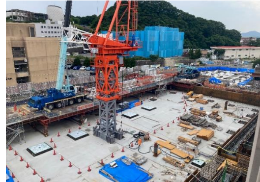
仮設タワークレーンの設置
