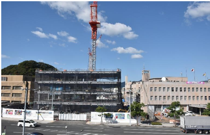
5階床までの柱・梁・床組みが完了
