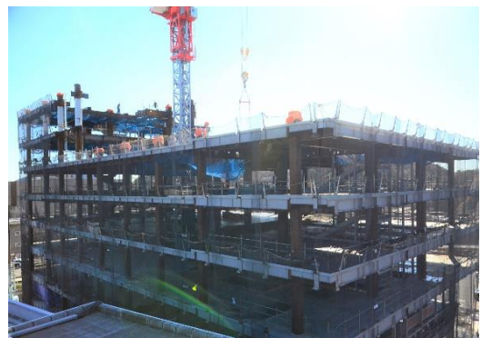
8階床の鉄骨工事に着手
