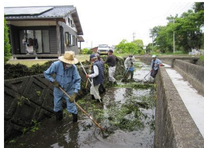
水路の泥上げ
