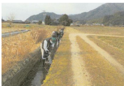
水路の泥上げ
