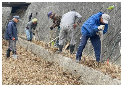
水路の泥上げ
