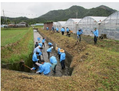
水路の草取り、泥上げ
