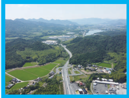
国道2号台道拡幅
