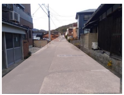
主要観光地周辺の道路修景工事
