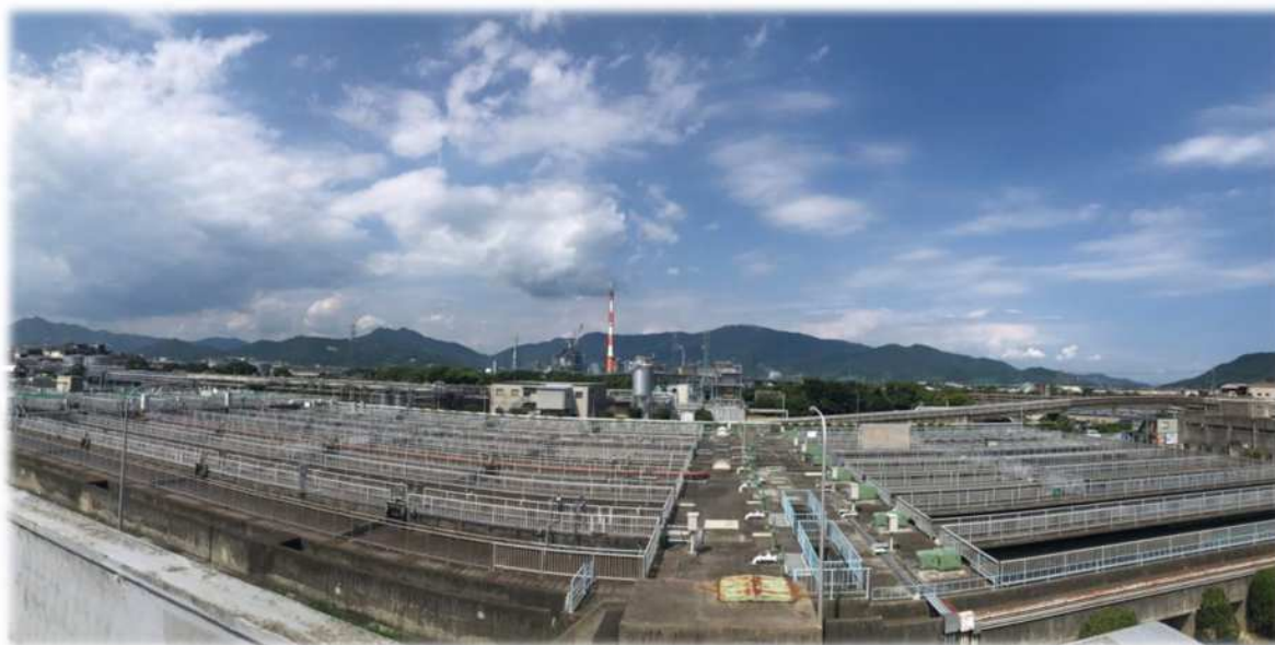
図-26 防府浄化センター
