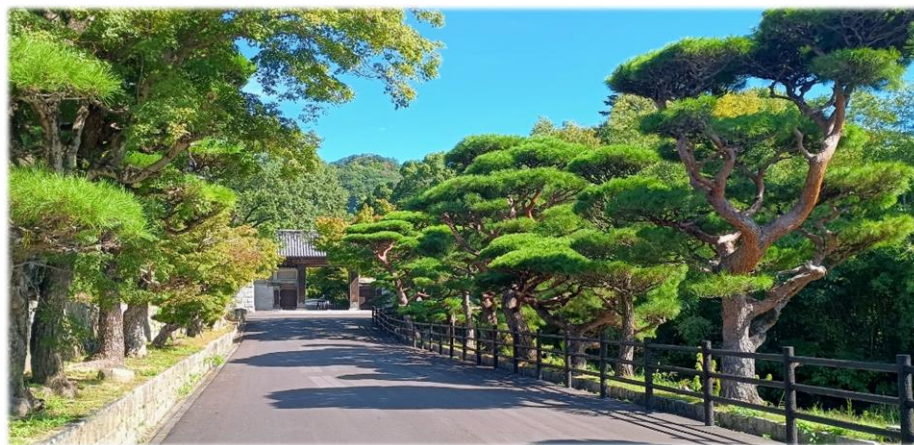
1-①・② 毛利氏庭園本門前道路修景整備、防護柵改修
