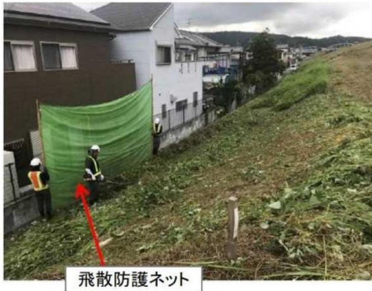
写真2 刈払機と防護ネットの組み合わせ例（参考写真）
